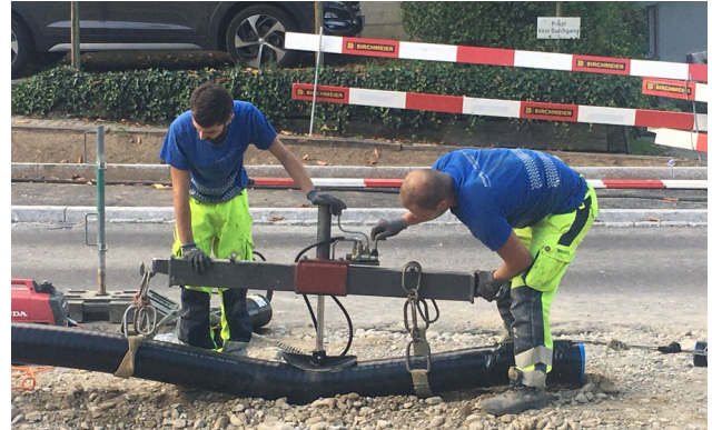
Flexibles Rohr wird vor Ort gerichtet
