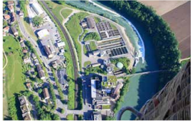
Der Laufäcker in Turgi mit KVA und Kläranlage sowie dem Merz-Areal (oben links, ennet der Bahnlinie), das der Gemeindeverband jetzt gekauft hat. (Foto: Franz Killer)
