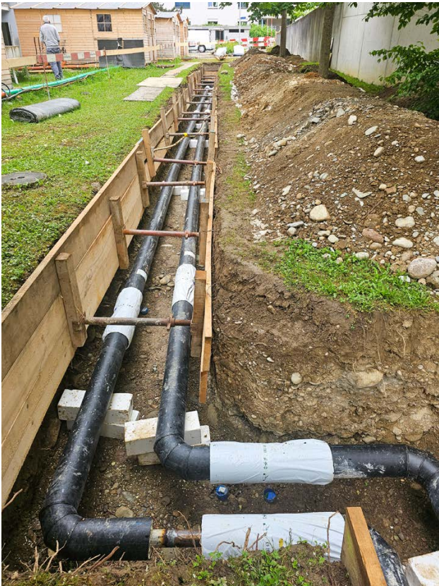
Fernwärme Leitungsbau
